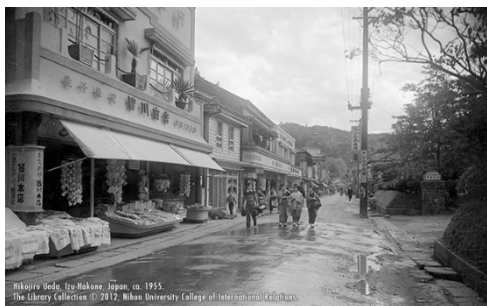
参考：通りに開かれた昔の温泉場出逢い通り
