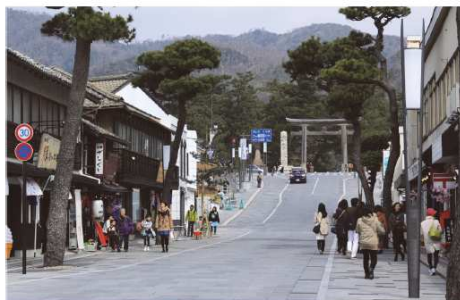
歩行空間が広く感じられるよう、中央線を消去するとともに、路側帯の舗装パターンを区画線の内側にしみ出すように整備（島根県出雲市 神門通り） 資料提供：島根県
